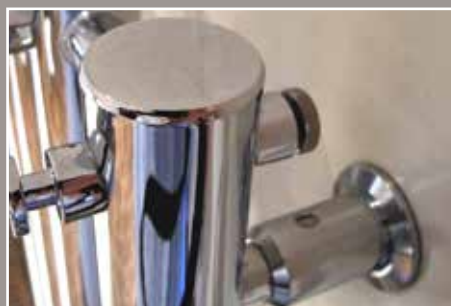
Entlüftungsventil auf der Rückseite des Heizkörpers
